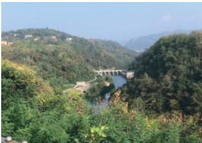
Una delle numerose dighe che contraddistinguono questo tratto dell'Adda
