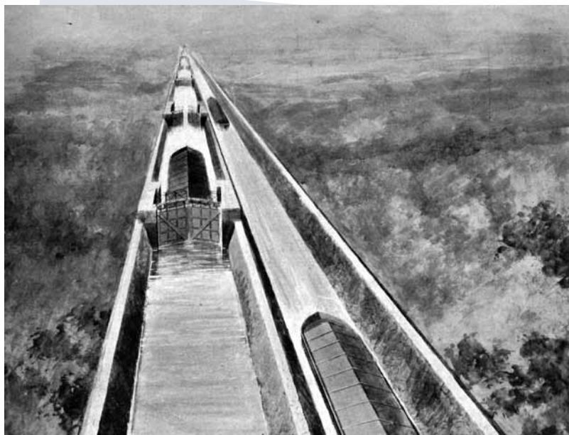
Particolare delle chiuse.
